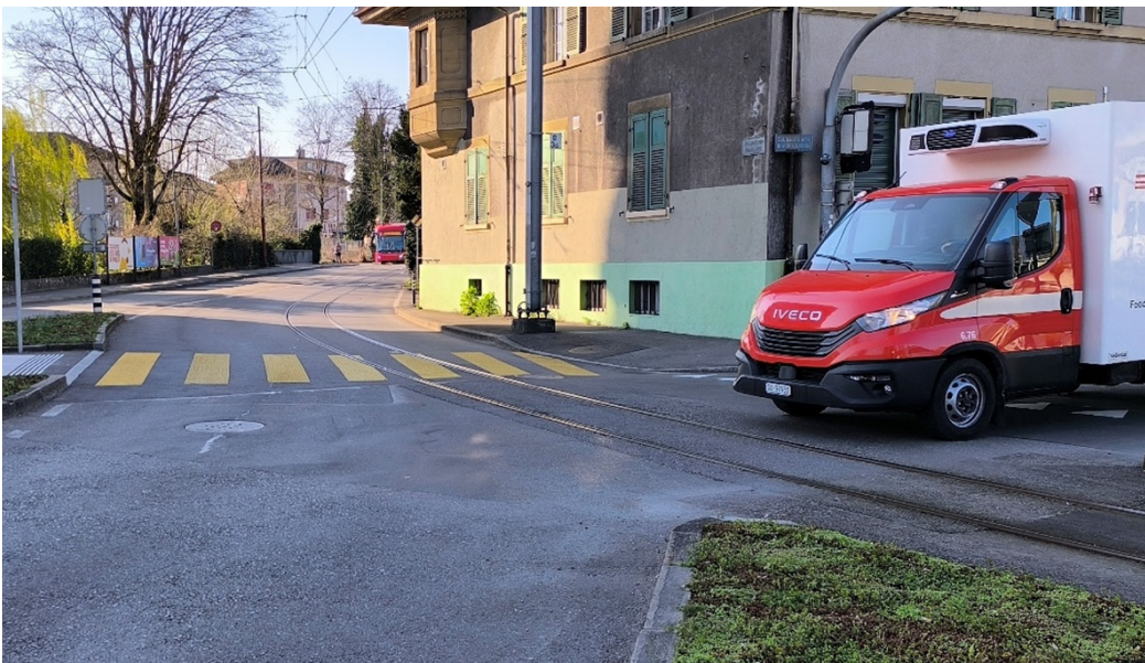
Abbildung 10: Spitzwinklige Gleisquerung (Schweiz)
