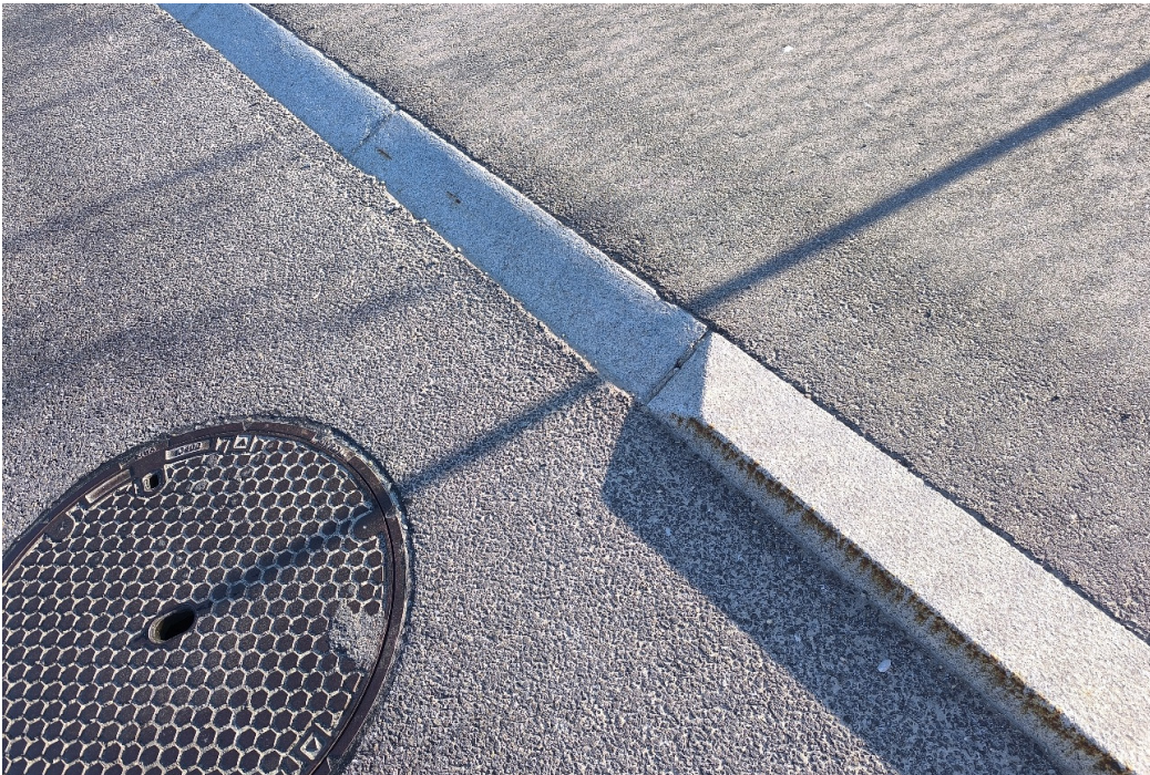
Abbildung 5: Zu kurzer und zu steiler Einfädelungsbereich auf einen Radweg (Schweiz)
