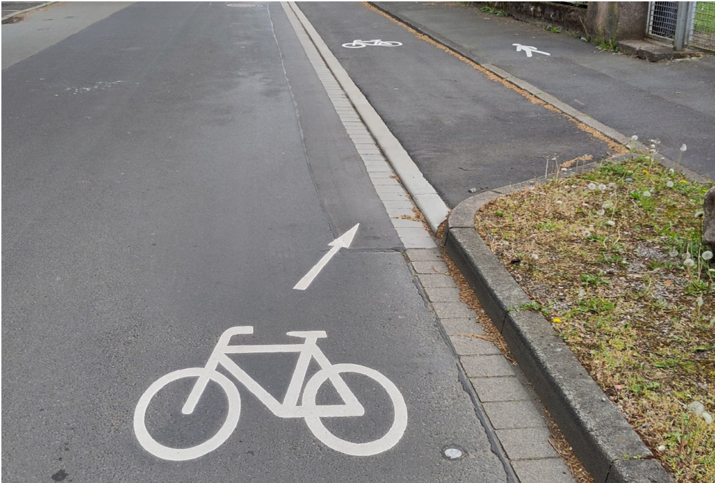
Abbildung 4: Verbleibende Höhendifferenz an einem Übergang in den Seitenraum (Deutschland)
