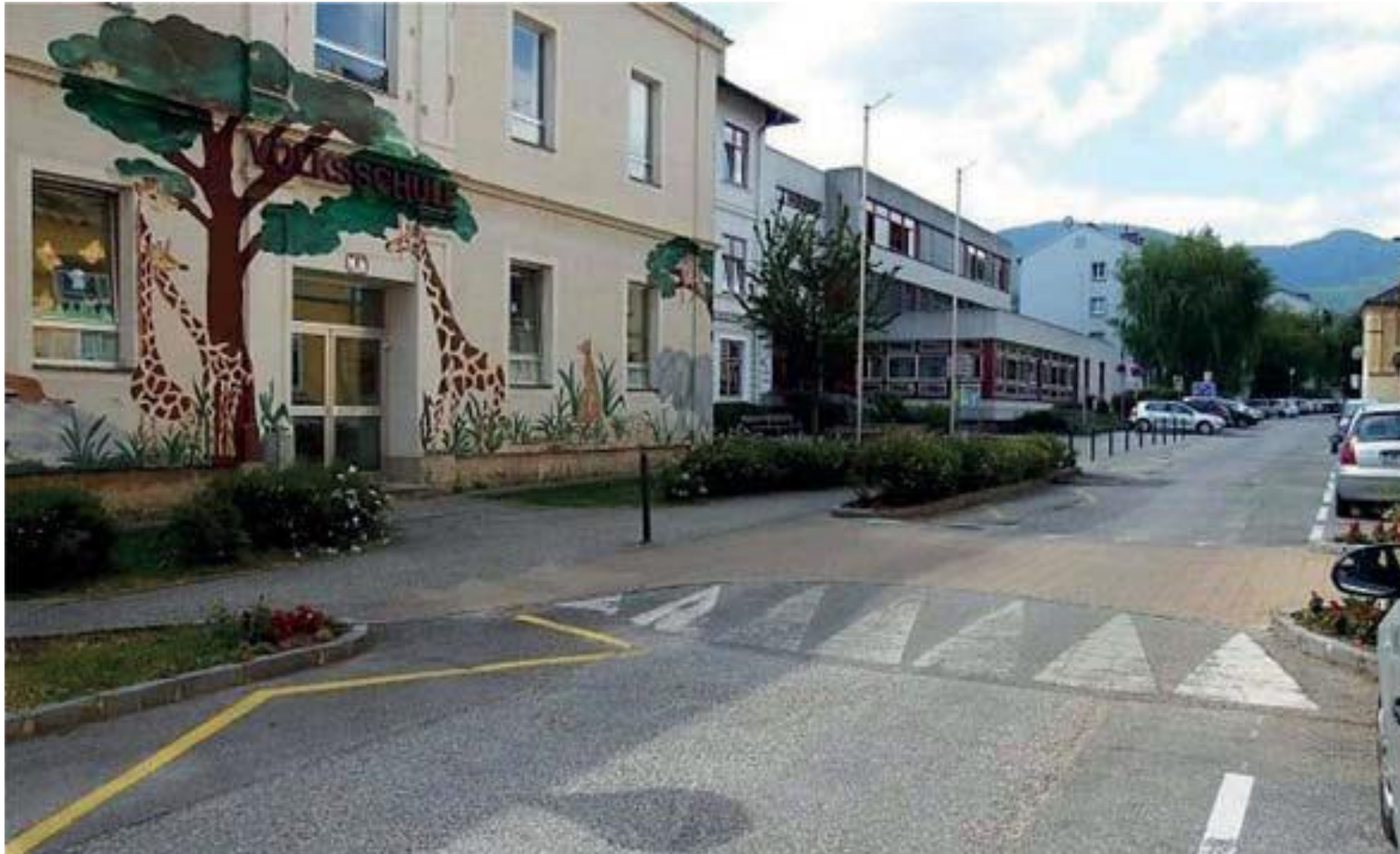
Gelb gepflasterte Fahrbahnanhebung direkt vor dem Eingang der Volksschule
