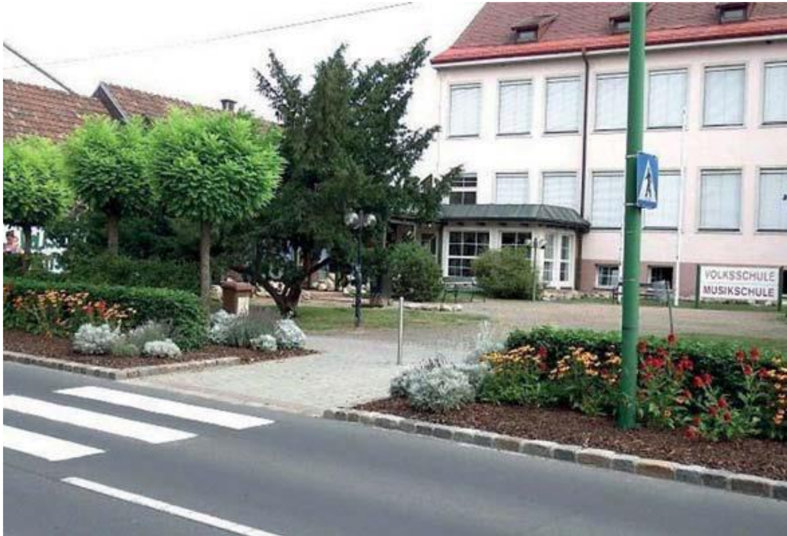
Gehsteigvorziehung beim Schutzweg mit niedriger Bepflanzung
