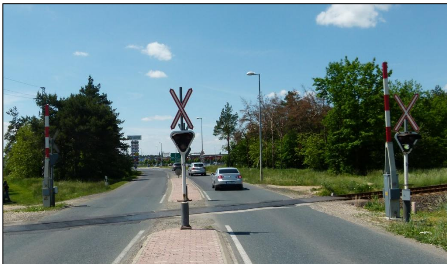
53. ábra: Félsorompóval kiegészített fénsorompó és középső elválasztó Magyarországon
