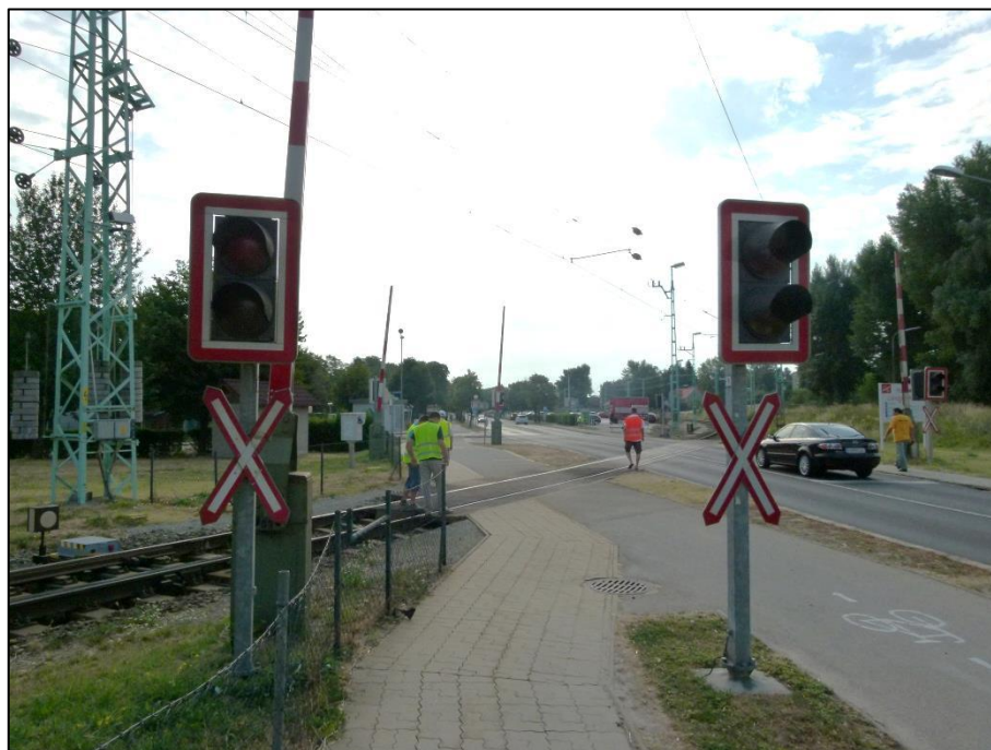
56. ábra: Sorompóval kiegészített fény sorompó Ausztriában a nem motorizált egyéni forgalom számára
