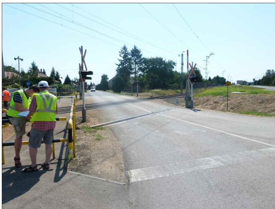
XXX. ábra: SR3-as vasúti átgázó, túl rövid felállási szakasz
