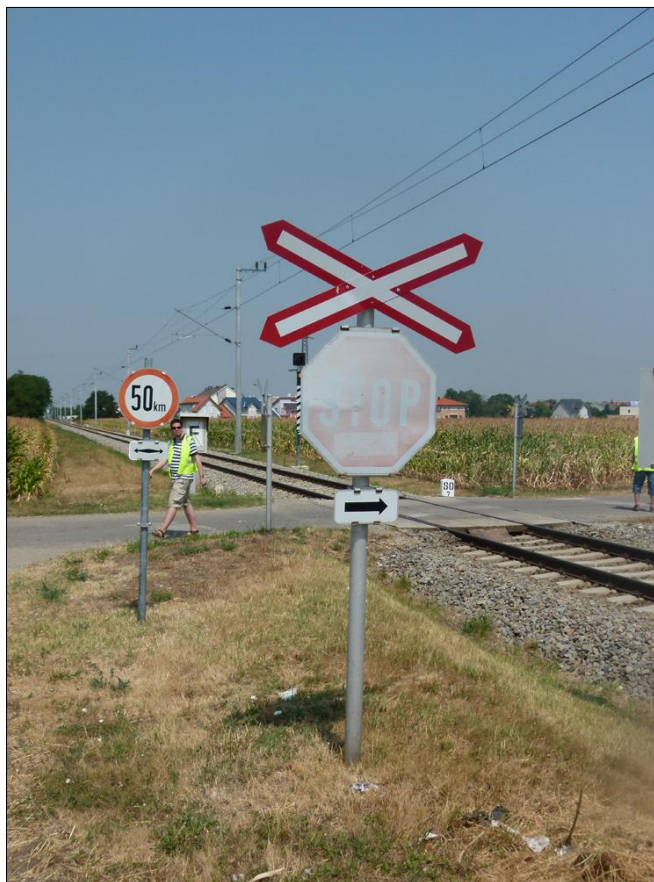
LXXVII. ábra: EK80,694-es vasúti átjáró, földút: erősen kifakult stoptábla
