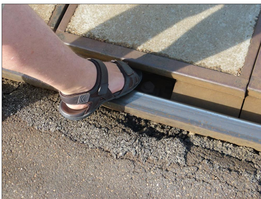
LVI. ábra: AS52-es vasúti átjáró, rés a sín és a betonelem között
