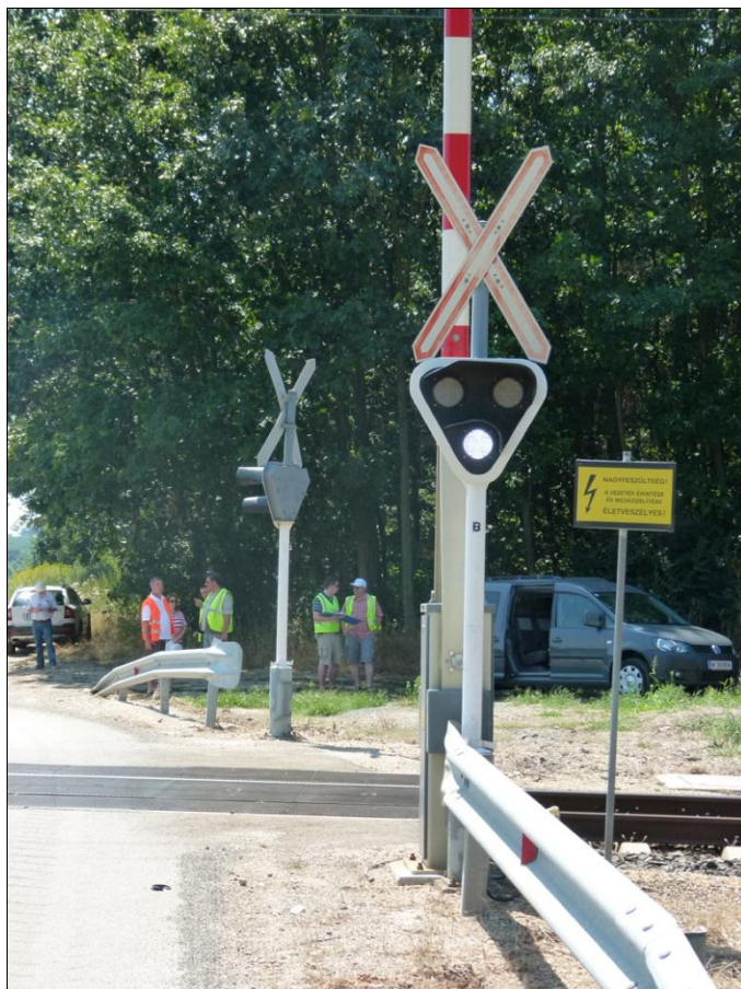
XXXVII. ábra: AS759-es vasúti átkelő, LED-optikus fénySOROMPÓ
