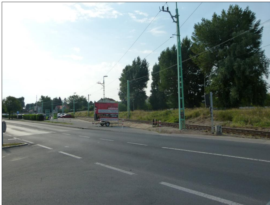
LXV. ábra: EK114,309-es vasúti átjáró, 2. irány: a látást reklámtábla akadályozza
