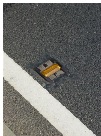
64 ábra: Útburkolatba helyezett fényvisszaverő prizma áttekintő képe (bal oldalon) és közeli felvétele (jobb oldalon)
