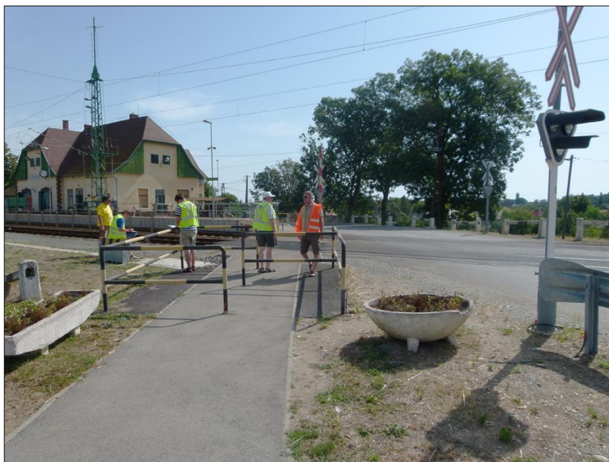
LXI. ábra: SR1-es vasúti átjáró, 1. irány: terelőkorlát
