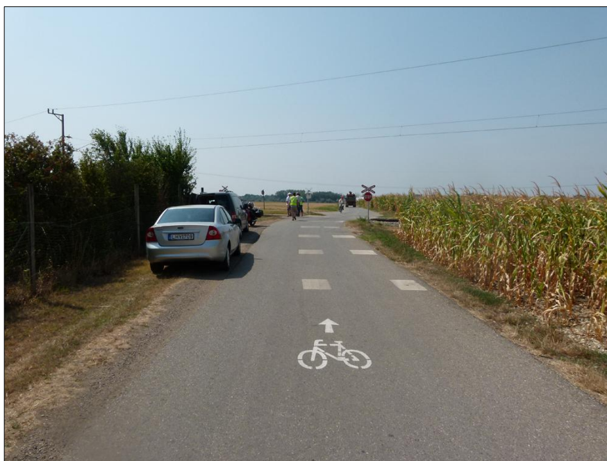
LXXVI. ábra: EK80,694-es vasúti átkelő, 2. irány: a veszélyes hely előjelzésére szolgáló vonalak
