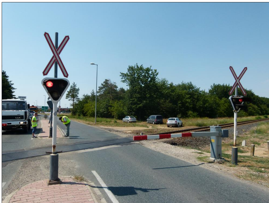
LI. ábra: AS155-ös vasúti átfjáró, 1. irány
