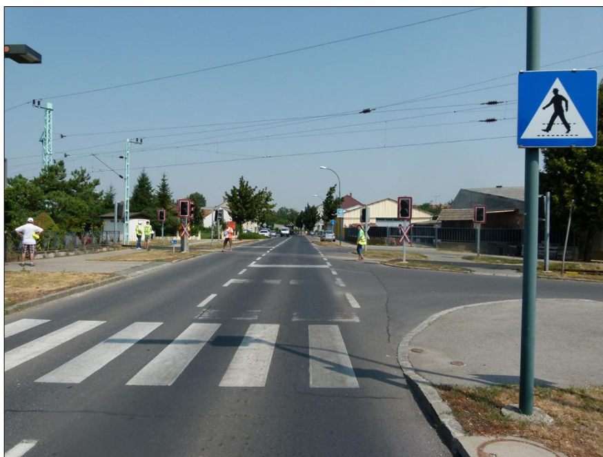
LXXII. ábra: EK87,650-es vasúti átvjáró, 1. irány: a veszélyes hely előjelzésére szolgáló vonalak megkoptak
