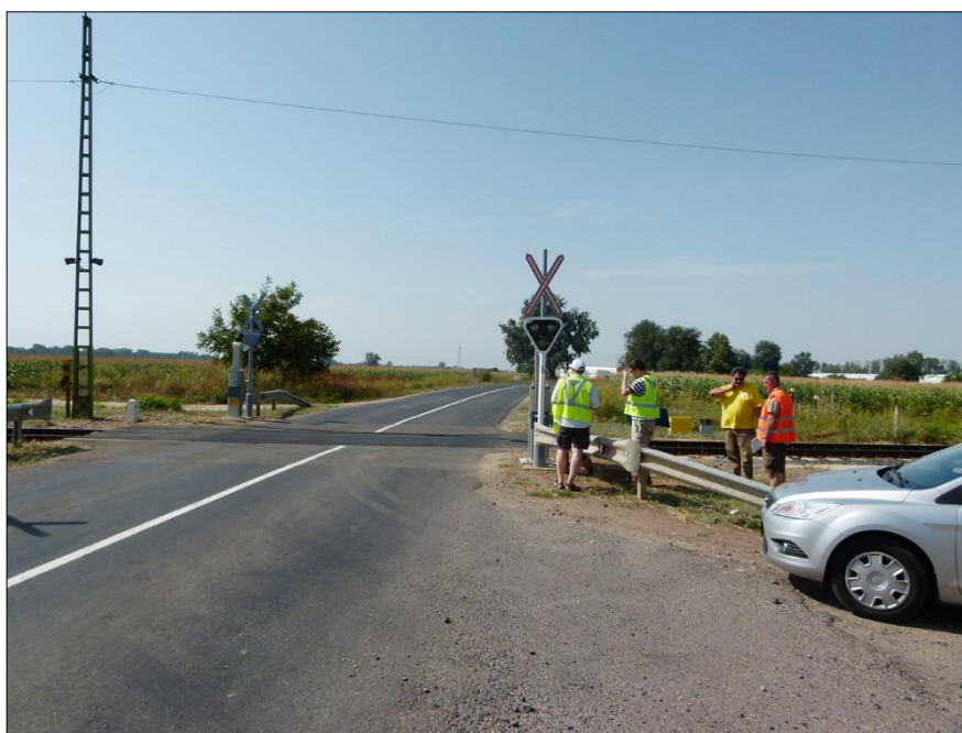
XLI. ábra: SR1-es vasúti átfjáró, 2. irány
