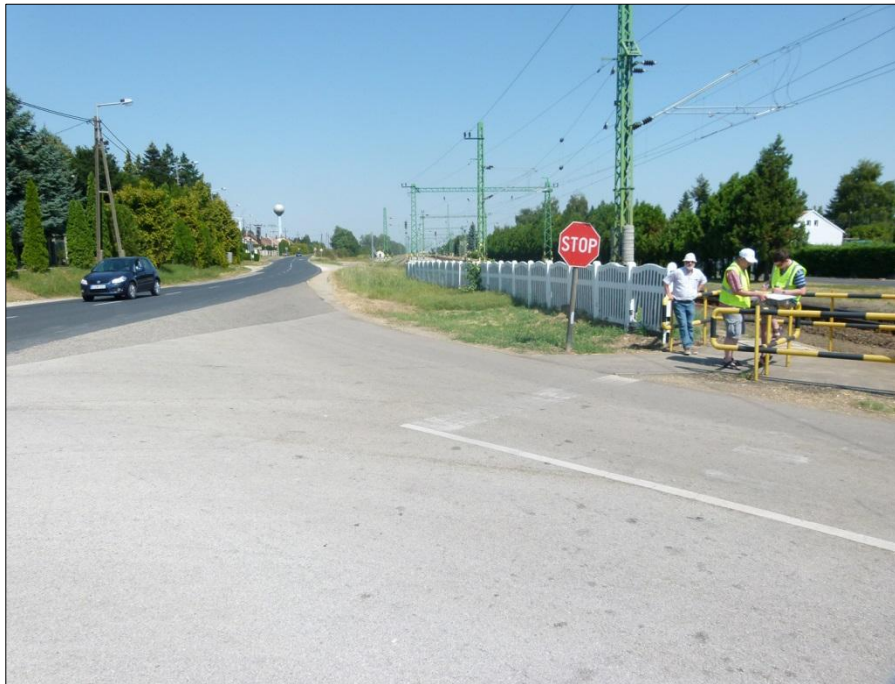
XXXI. ábra: SR3-as vasúti átvjáró, a felállási szakasz előrébb helyezése
