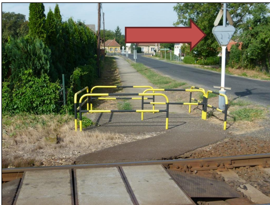
57. ábra: Gyalogos-átkelőhely vasúti átjáróban hátsó fény nélkül
