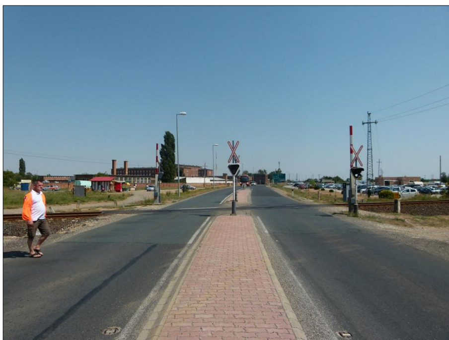
LII. ábra: AS155-ös vasúti átfjáró, 2. irány
