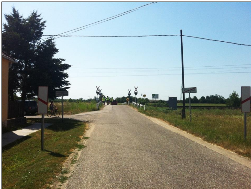
VI. ábra: AS510-es vasúti átfjáró, 1. irány
