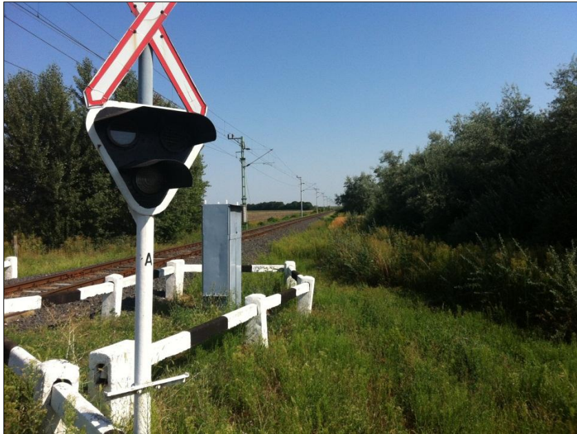
X. ábra: SR2-es vasúti átjáró, fényesorompó
