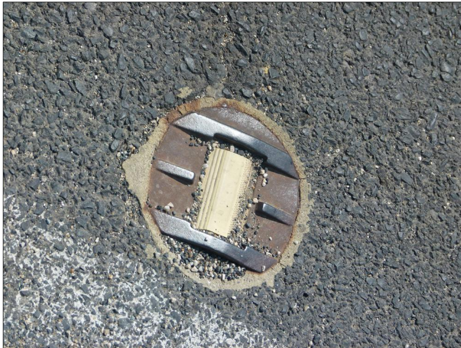
LIII. ábra: AS155-ös vasúti átjáró, a fényjelzők erősen kopott fémtestjei
