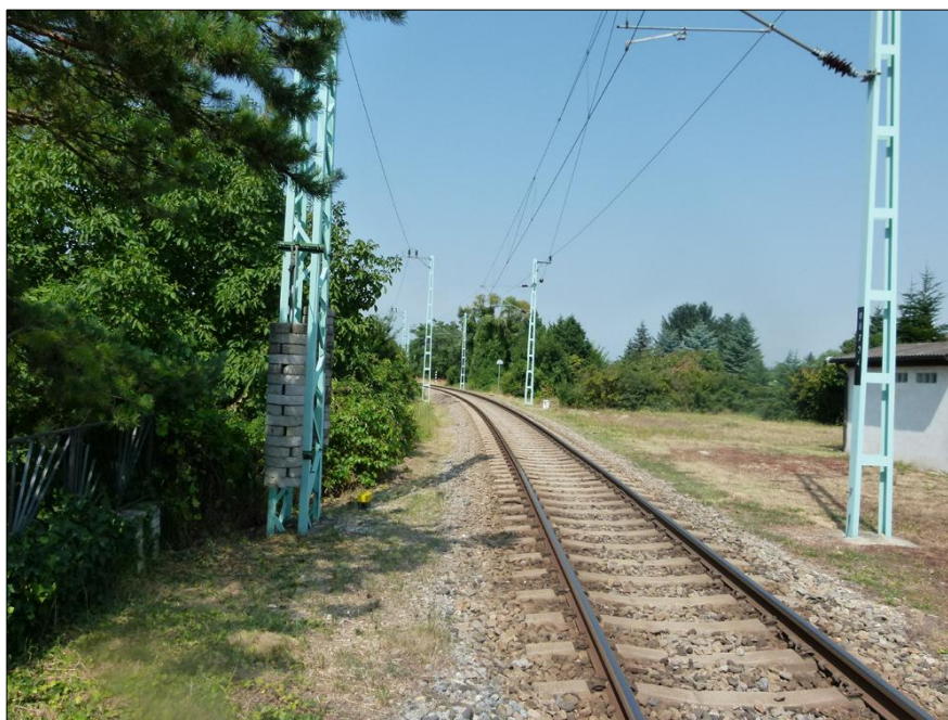
23. ábra: Az EK 87.650-es vasúti átvjáró, látótávolság: 93 m
