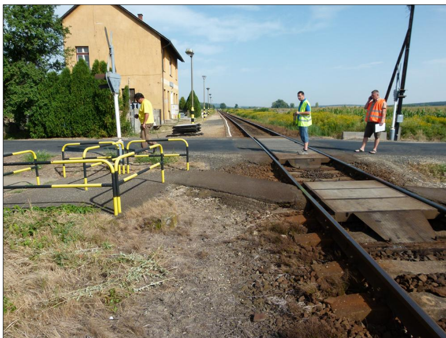
LV. ábra: AS52-es vasúti átjáró, gyalogút a terelőkorlát és a sín között
