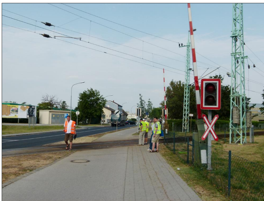
LXIV. ábra: EK114,309-es vasúti átkelő, sorompóval biztosított gyalogos és kerékpáros-átkelőhely
