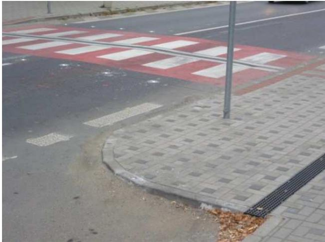
Die Fläche ist mit einer spürbaren Pflasterung gemäß Anordnung 532/2002 GBI. und Anordnung 9/2009 GBI. versehen (Warnpflaster und Leitlinie).
