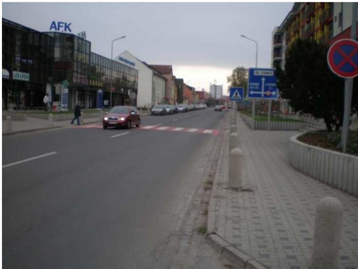
Die Umsetzung der Maßnahmen erfolgt auf Grundstücken, die im Eigentum der SSC liegen und derzeit als Straße dienen. Der Anschluss der Schutzwege an die bestehenden Gehsteige erfordert deren Höhenanpassung (Änderung der Pflasterung). Die Gehsteige liegen im Eigentum und auf Grundstücken des Bauherrn - der Stadt Malacky.
