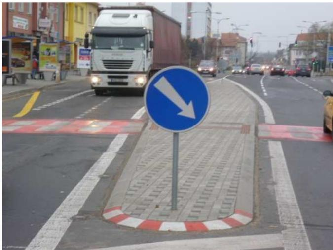
Der Verkehrinselrand besteht aus abgeschrägten, in Beton liegend verlegten Straßenbordsteinen. Der Raum zur Errichtung der Verkehrinselkonstruktion wird durch ein 0,3m tiefes Ausschneiden und Herausreißen der Fahrbahn geschaffen.
