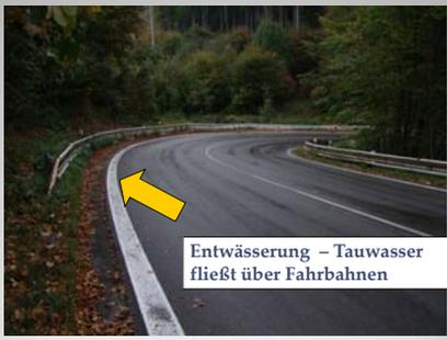
Entwässerung – Tauwasser fließt über Fahrbahnen
