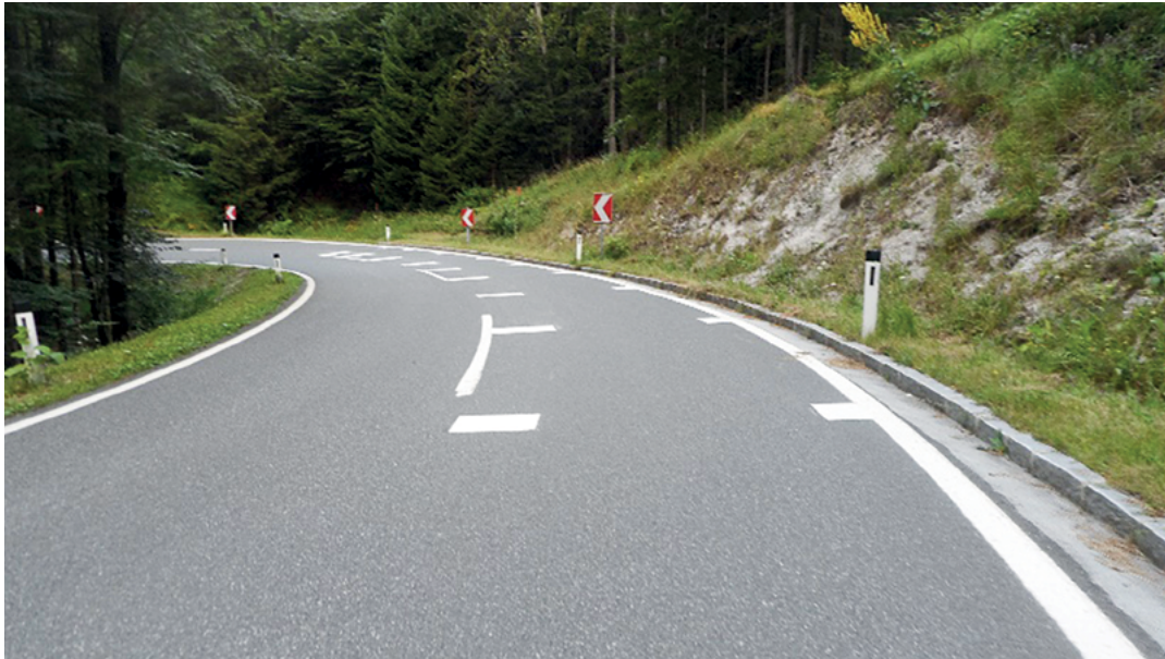
Abbildung 12: Sondermarkierung gegen Kurvenschneiden 38
