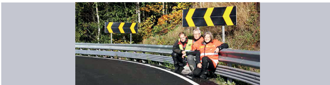
Abbildung 8: Kunststoffrohre als Unterfahrschutz bei Leitschienen 14
