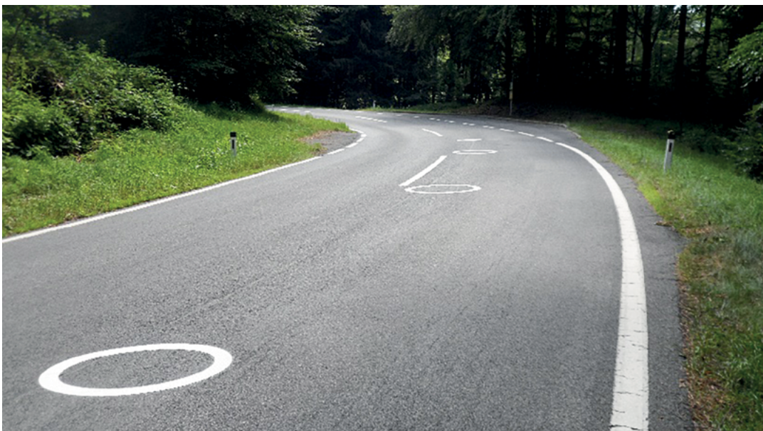
Abbildung 11: Sondermarkierung gegen Kurvenschneiden 37
