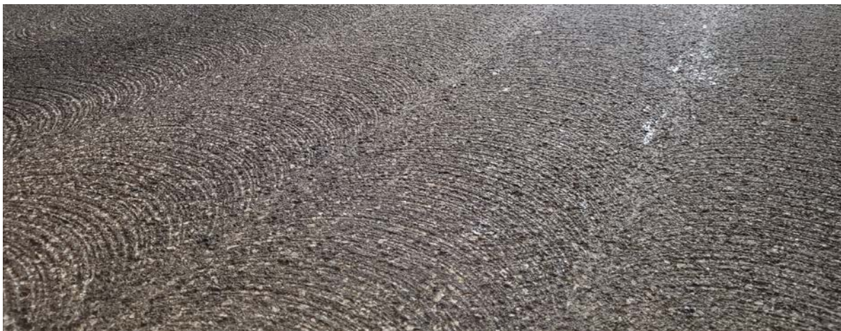
ABBILDUNG 135: L266 bei km 5,1, Feinfräsung
