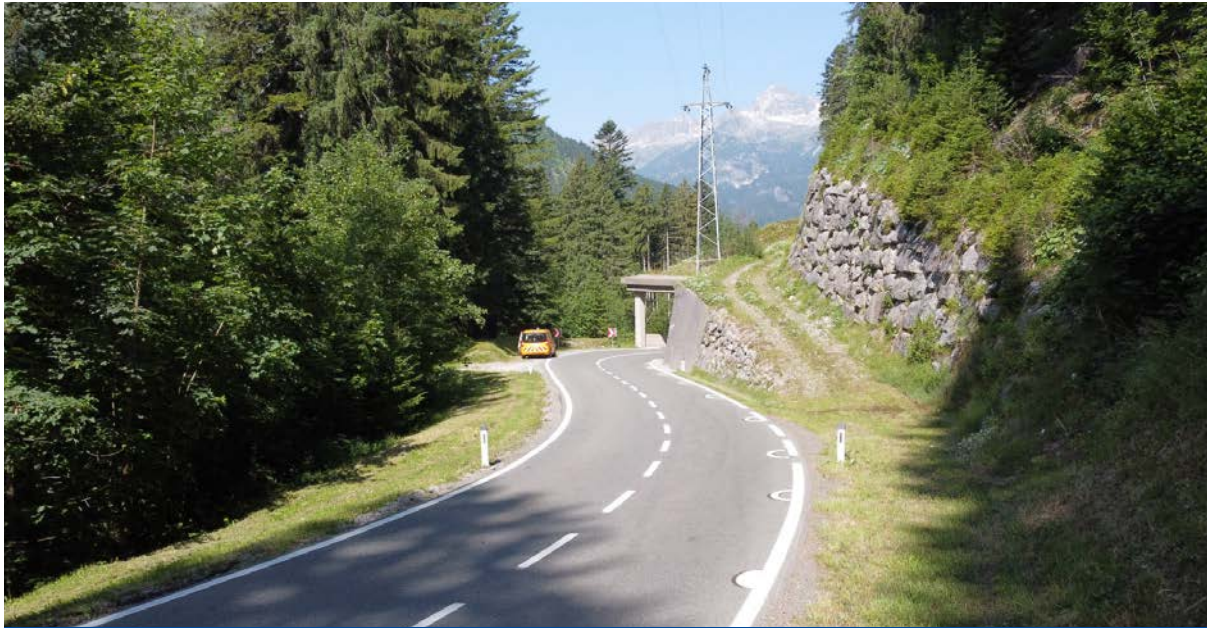
ABBILDUNG 131: L266 bei km 3,25, Bergseite der Galerie, fertige Bodenmarkierungen
