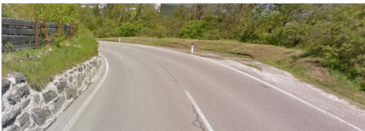
ABBILDUNG 106: B182 bei km 5,35 Street View talauswärts
