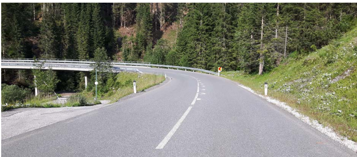
ABBILDUNG 60: Ellipsenmarkierungen und ein Leitwinkel wurden platziert, L21 Berwang-Namloser Straße km 10,3
