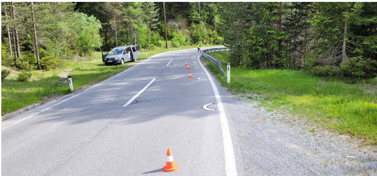
ABBILDUNG 108: B185 bei km 6,4, Eigenes Bild während der Markierungsarbeiten
