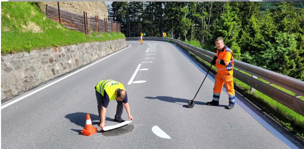
ABBILDUNG 35: B182, Brennerstraße, km 11,5, Fotos während der Markierungsarbeiten
