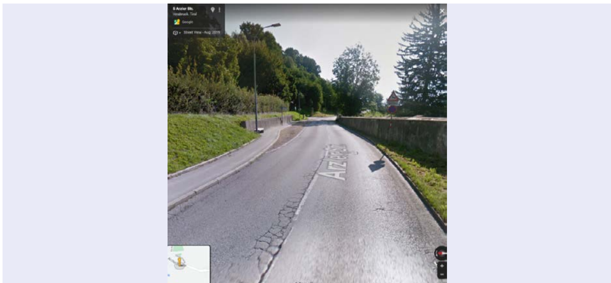
ABBILDUNG 97: Google Maps. Innsbruck, Arzler Straße stadtauswärts vor dem Mühlweg
