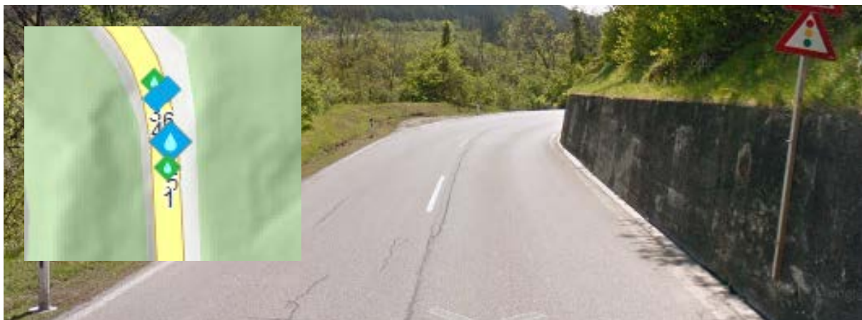
ABBILDUNG 105: B182 bei km 5,35, Street View taleninwärts
