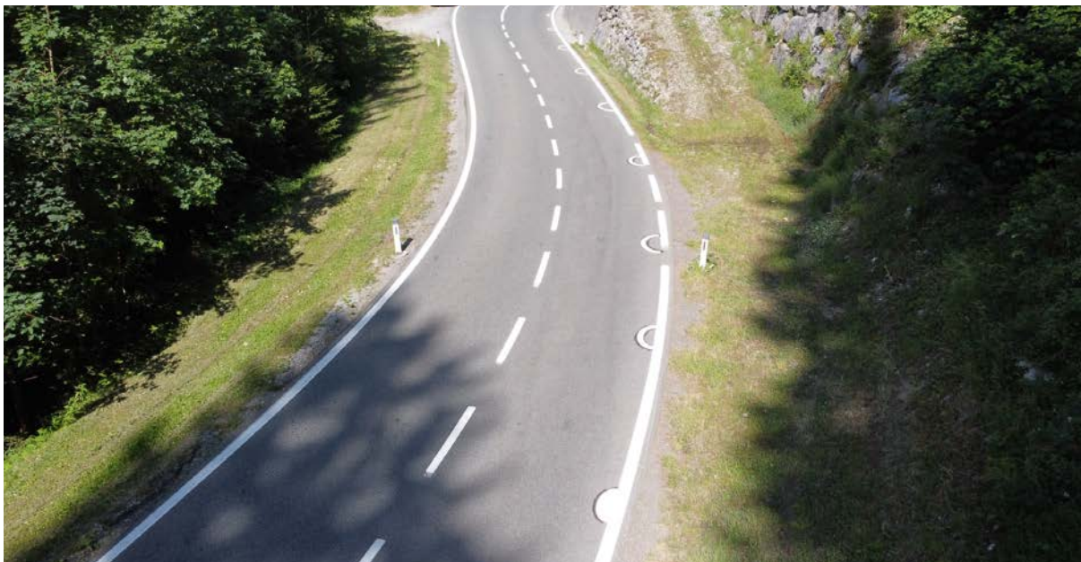
ABBILDUNG 132: L266 bei km 3,25, Talseite der Galerie, fertige Bodenmarkierungen
