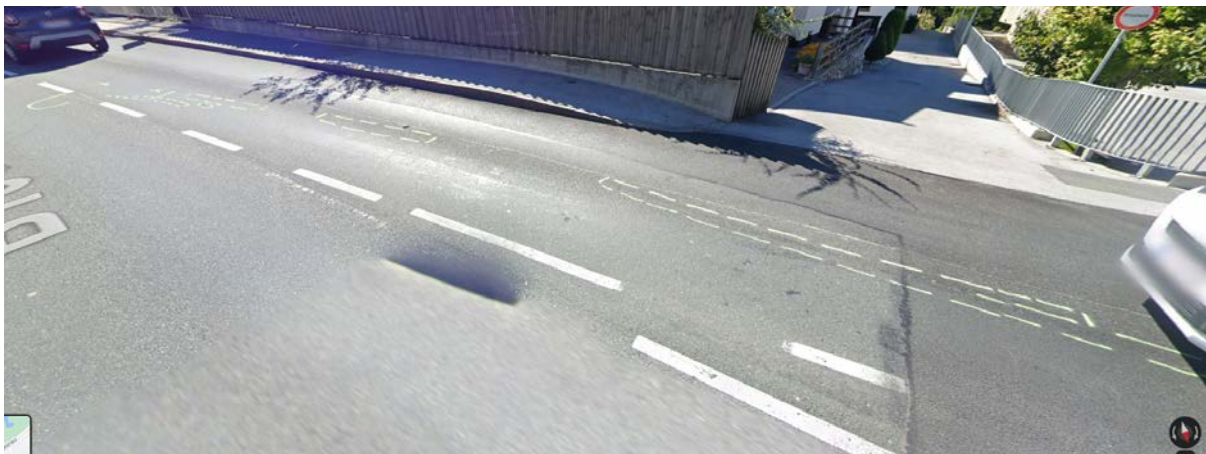
ABBILDUNG 152: Unfallstelle in Kitzbühel, Google Street View
